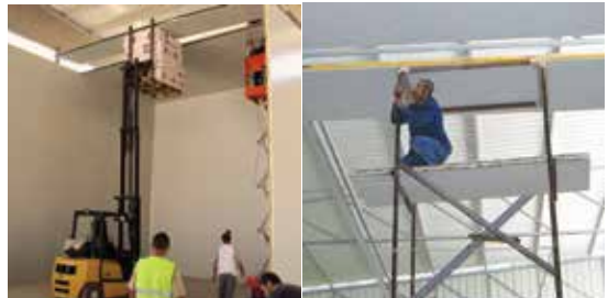
Depo bölmelerinin montajı
