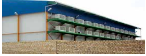
Split Sistem Uygulaması Aktau (Kazakistan)
