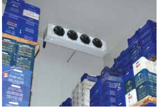
İç ünitelerin uygulaması
