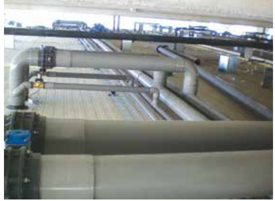
Atmosfer kontrollü deponun çatı arası
