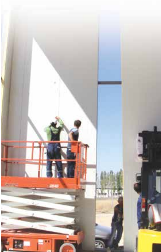
Montaj, yan duvarların, köşeleriyle başlar
