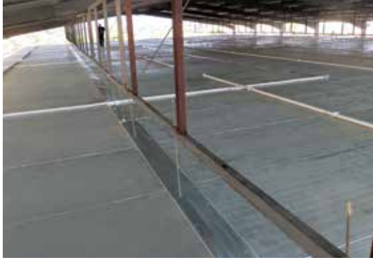
Tavan panellerini birleştirmek için kullanılan tavan askısı ve birleşim yeri
