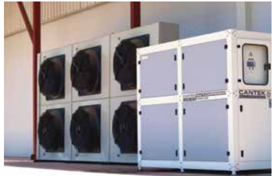
Dış ünitelerin uygulaması
