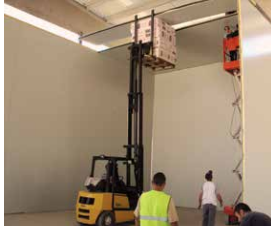
Depo bölmelerinin montajı
