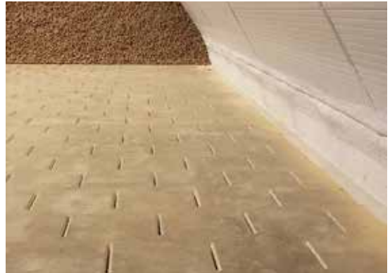
Yığın halinde soğan depolamasında zemindeki hava kanalları
