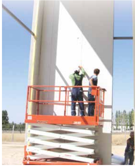
Montaj, yan duvarların, köşeleriyle başlar
